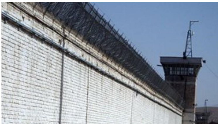
نمای بیرونی دیوار و برج نگهبانی زندان وکیل آباد
